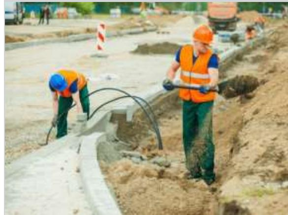
No tuerza la espalda, las rodillas ni el cuello al lanzar la carga. Dé un paso en la dirección del lanzamiento.
